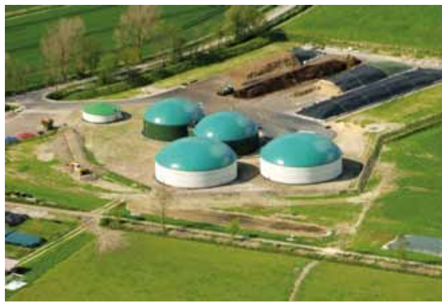
Centrale a biogas
