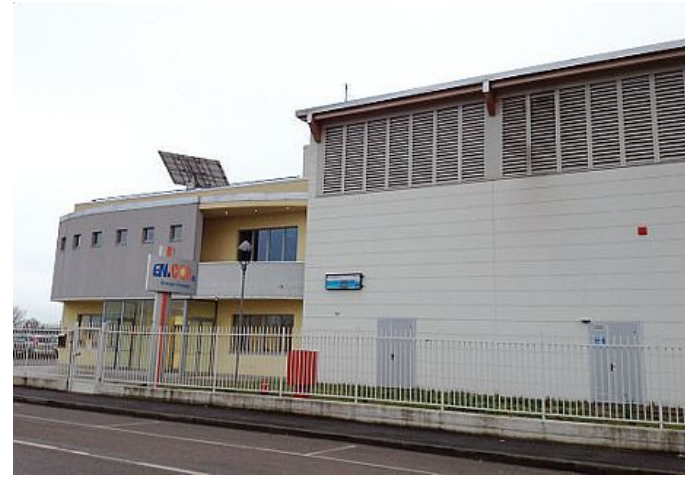
La centrale di produzione energetica di Correggio (ex En.Cor.)
