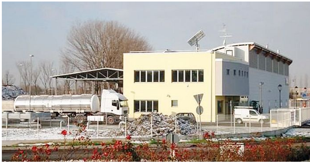
La centrale Eva di En.Cor, quando ancora vi venivano conferiti i materiali per farla funzionare
