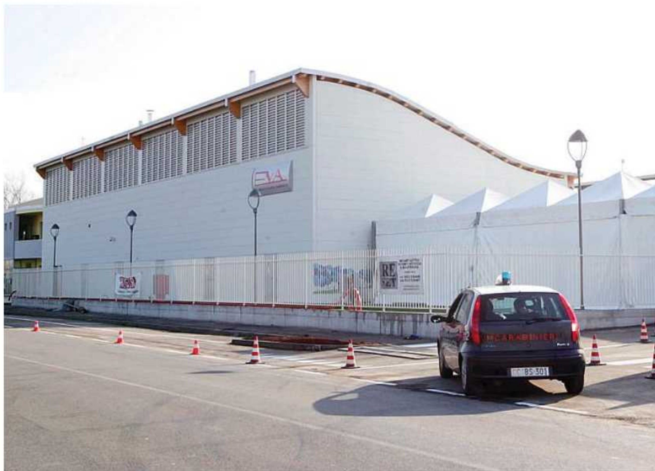
La centrale energetica Eva (energia valore ambiente) ceduta alla società Amtrade
