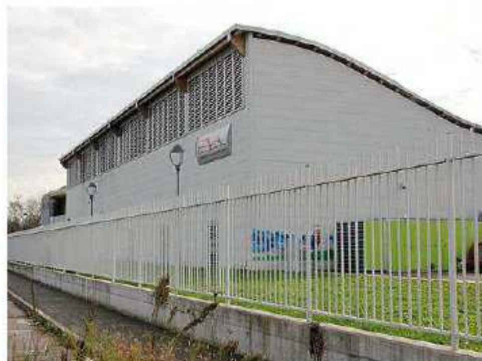
Lo stabilimento della En.Cor di Correggio
